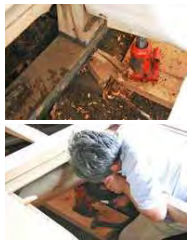
床の傾きを直すため、足固めの下にジャッキを入れて柱を持ち上げ、土台の下にくさびを打つ。このとき心の中で「ちゃんと直すなら、壁はらして家起こししねえといけねえなあ」と思っていたかもしれない
