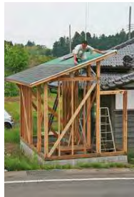
風呂・トイレ小屋を増築中。これが初めてのDIY。ベタ基礎を打ってコンクリートブロックで立ち上がりを作った
