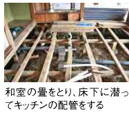
和室の畳をとり、床下に潜ってキッチンの配管をする
