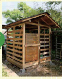
★ポイント 材料は、足間をSPF2×4材と白木にストックしてあった厚材。基礎は羽子板付きピンコロ石を地面に敷いただけの壁足をも。ヤギ小屋の向かいにある二ツ口小屋とつながるよう、長さ180cmの骨で割、後取場をつくった。
