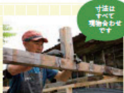
★古木の脚柱に梁を架してつなぐ。その真ん中に棟木を敷けるための小屋束を置き、1平全体で固定する。
