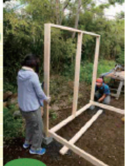
★脚柱の枠を立ち上げ、下側にSPF2×4材を架して脚柱の枠をつなぐ。
